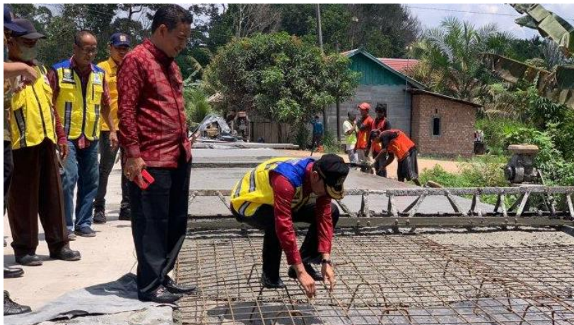
Ketua DPRD Provinsi Jambi Tinjau Pembangunan Jalan di Kumpeh
